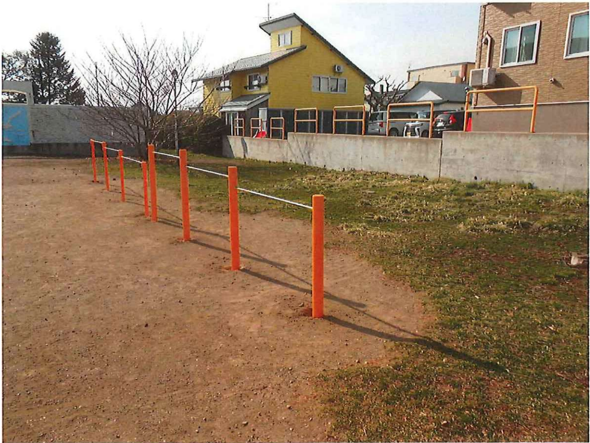
桔梗小学校（鉄棒3連プール側、鉄棒3連） 完成
