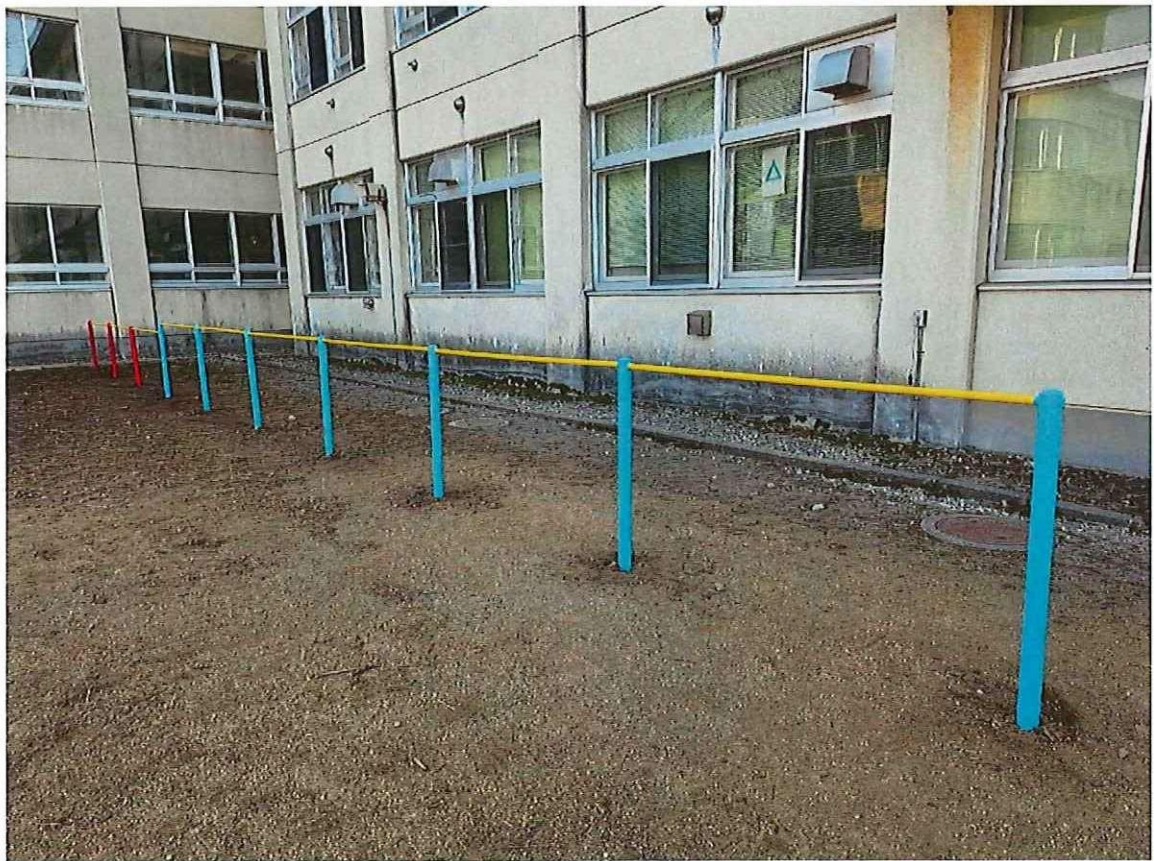
柏野小学校（鉄棒9連） 完成
