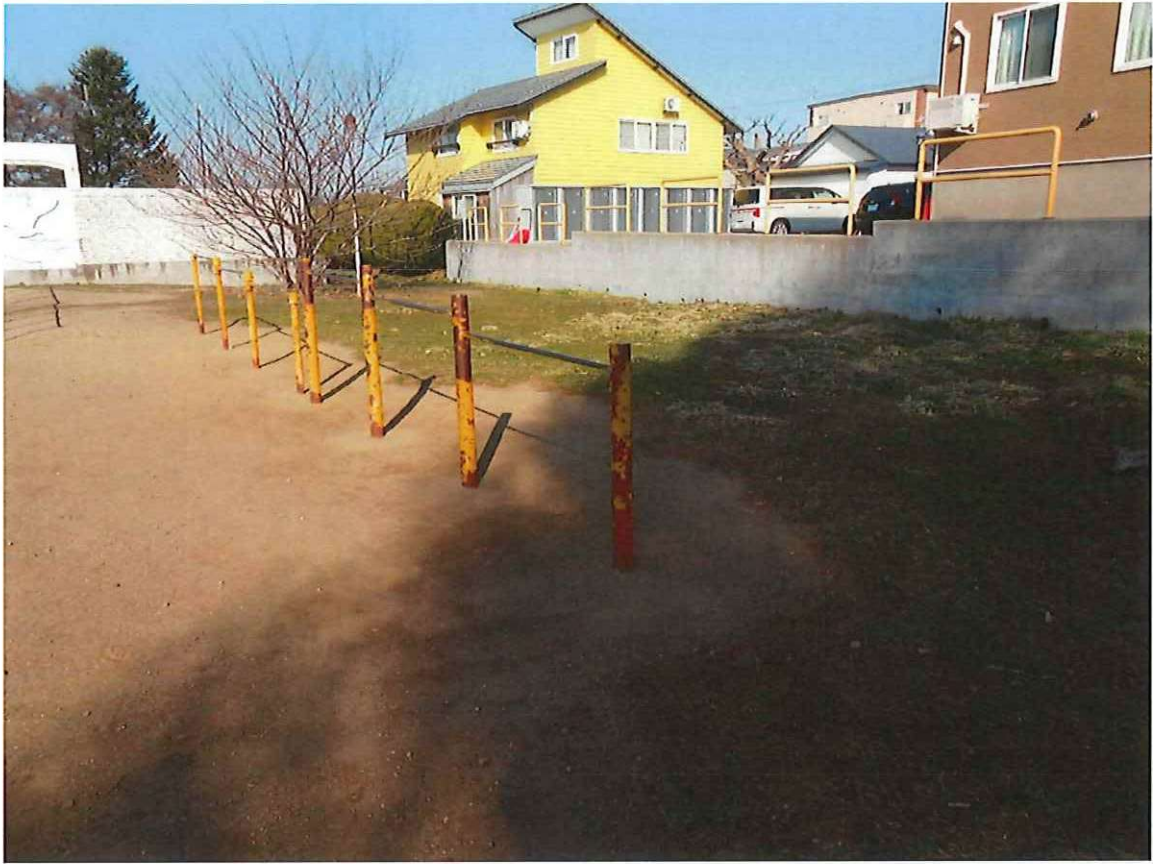
桔梗小学校（鉄棒3連プール側、鉄棒3連） 着手前
