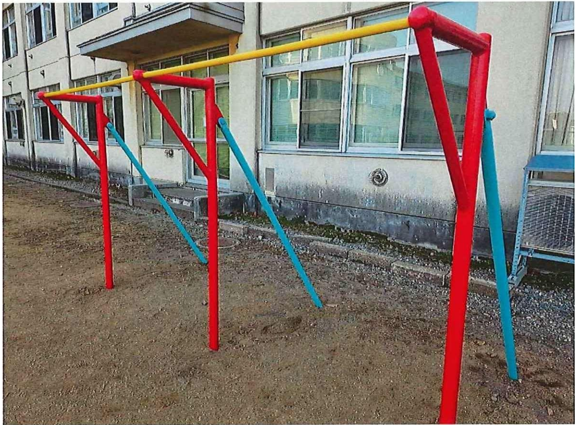
柏野小学校（鉄棒2連） 完成
