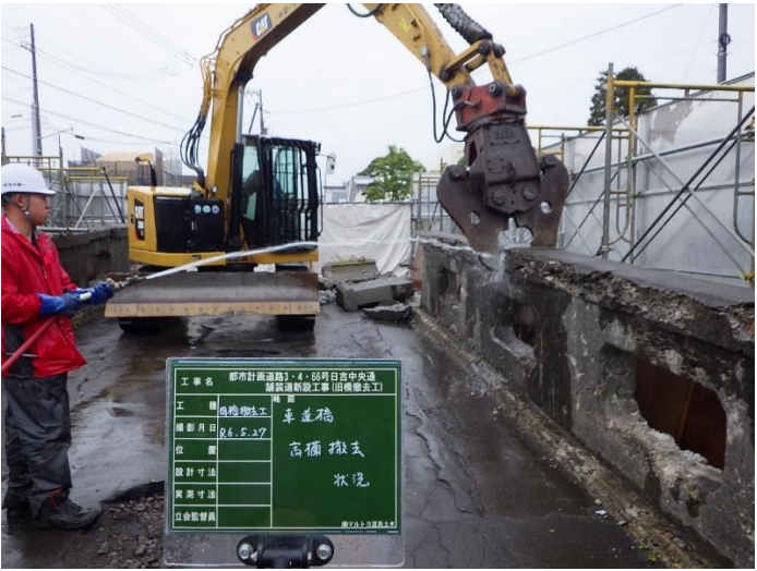
開進橋高欄撤去施工状況写真
