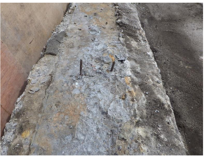
開進橋高欄撤去施工状況写真
