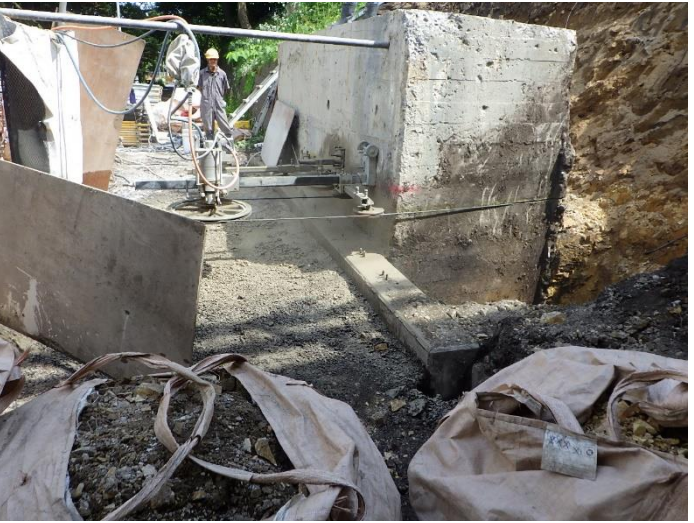
＜ワイヤーソー切断工法＞ 施工状況写真
