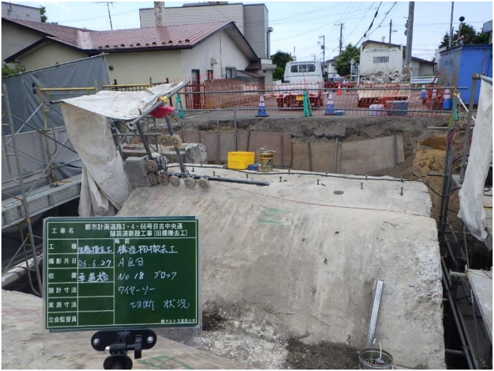
＜ワイヤーソー切断工法＞ 施工状況写真
