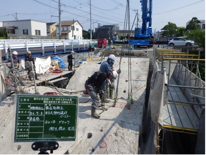
＜油圧式静的破砕工法＞ 施工状況写真
