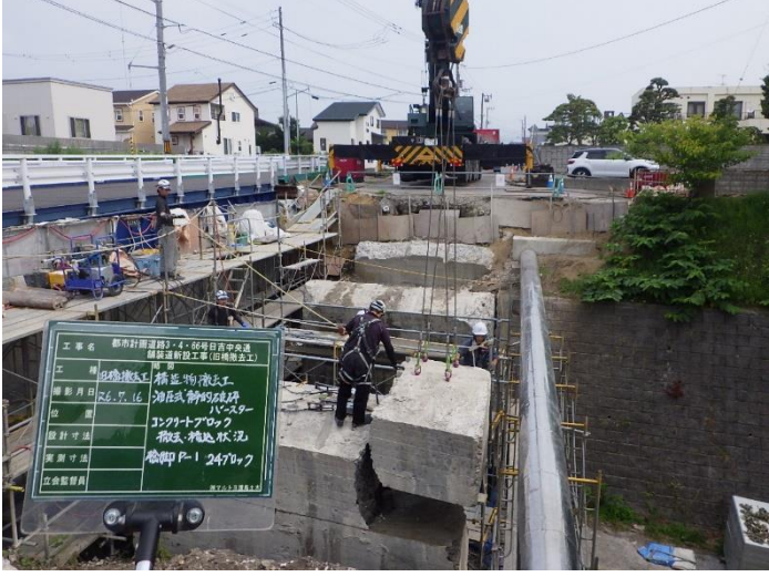
＜油圧式静的破砕工法＞ 施工状況写真
