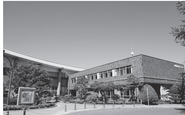
▲外観 会議室、和室、調理実習室、音楽室、体育館などがあり、さまざまなジャンルの活動に対応しています
