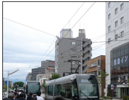
シンプルカタナリー方式吊架例
