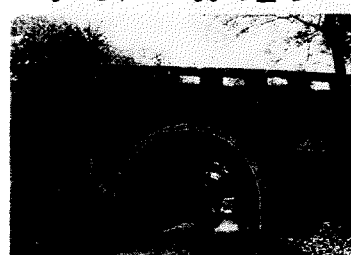
橋下からの景色がまもなく見納めとなる旧戸井線遺構の撤去
