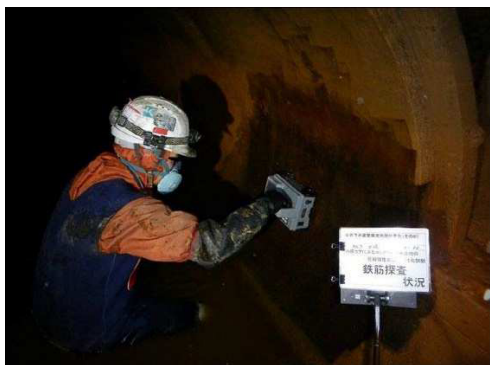
図参 1－鉄筋探査状況
