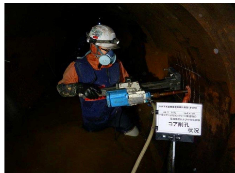
図参 5-コア抜き状況
