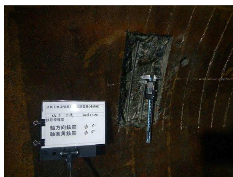
図参 2－鉄筋径確認状況
