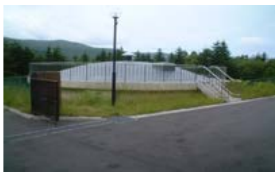
楢法華浄水場（配水池）
