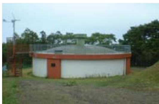
大船浄水場（配水池）
