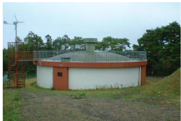
大船浄水場（配水池）
