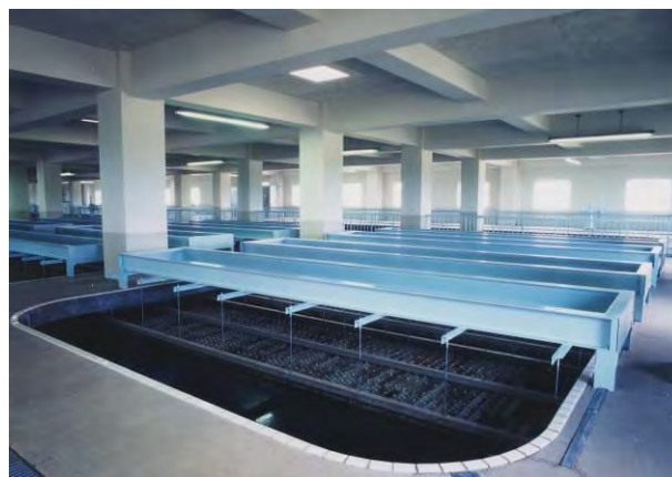
旭岡浄水場（薬品沈でん池）
