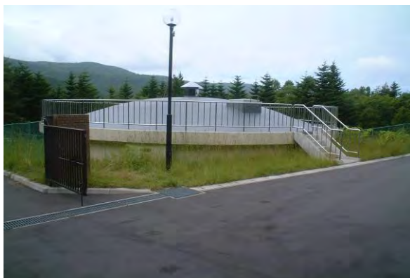
楢法華浄水場（配水池）
