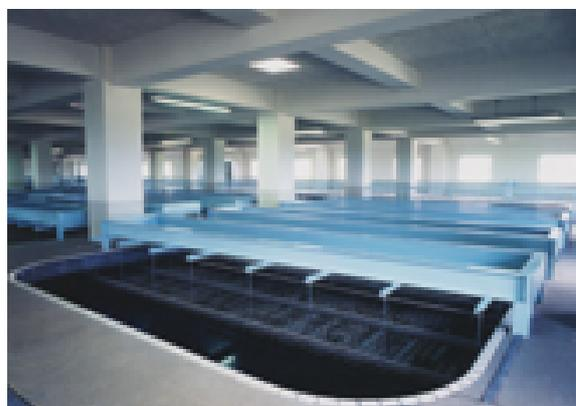
旭岡浄水場 (薬品沈でん池)
