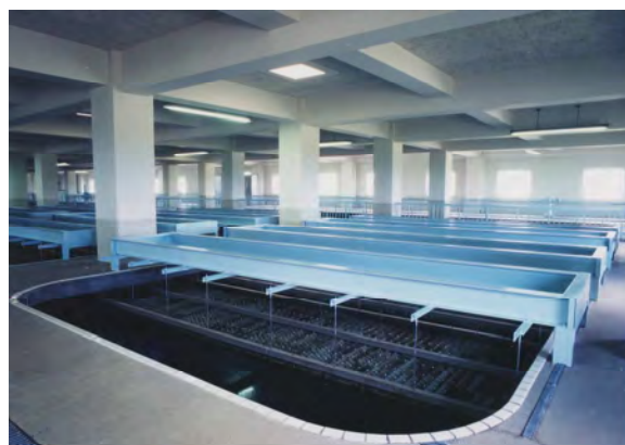
旭岡浄水場 (薬品沈でん池)
