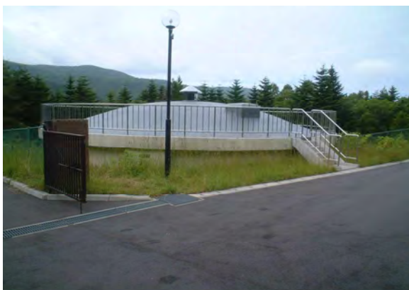
楳法華浄水場（配水池）
