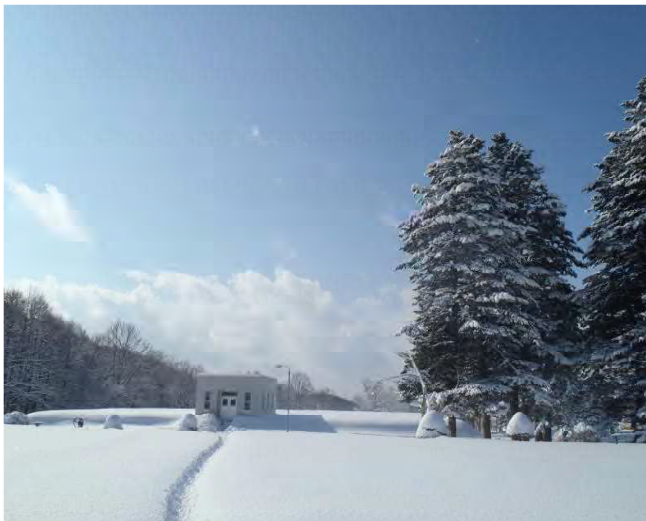
赤川高区浄水場構内
