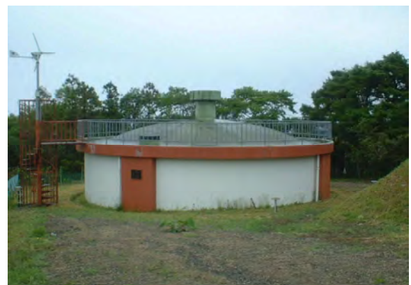
大船浄水場（配水池）
