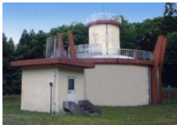
日ノ浜浄水場（配水池）
