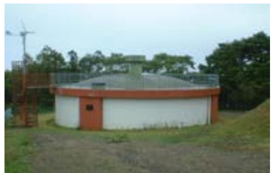
大船浄水場（配水池）
