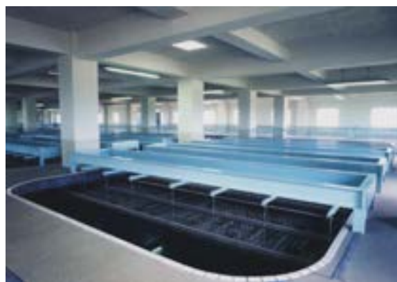
旭岡浄水場 (薬品沈でん池)
