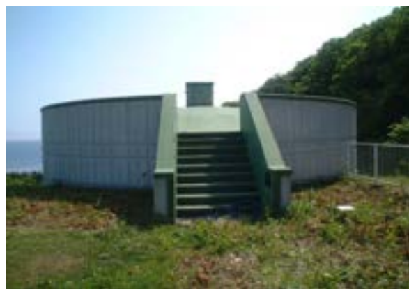
戸井西部配水池
