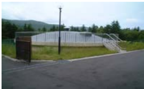
楸法華浄水場（配水池）
