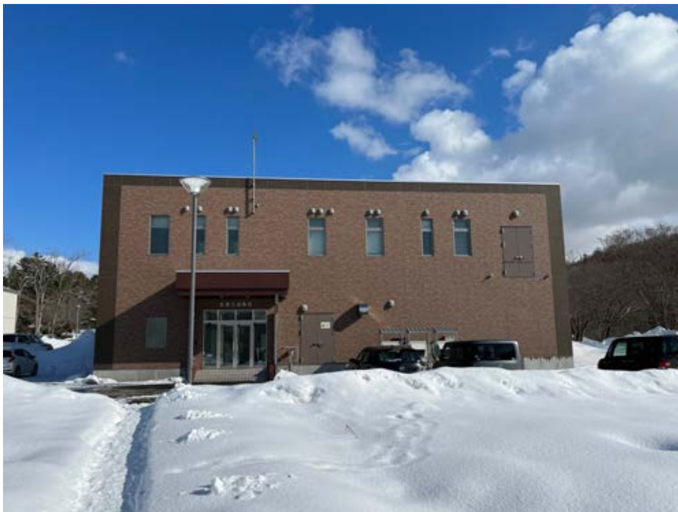
赤川高区浄水場 新ろ過施設
