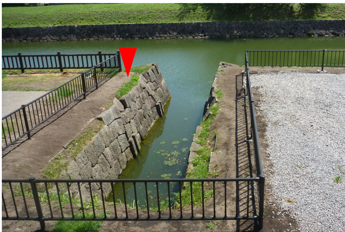
堀排水口部石垣 (西から) ▼で刃金板を確認
