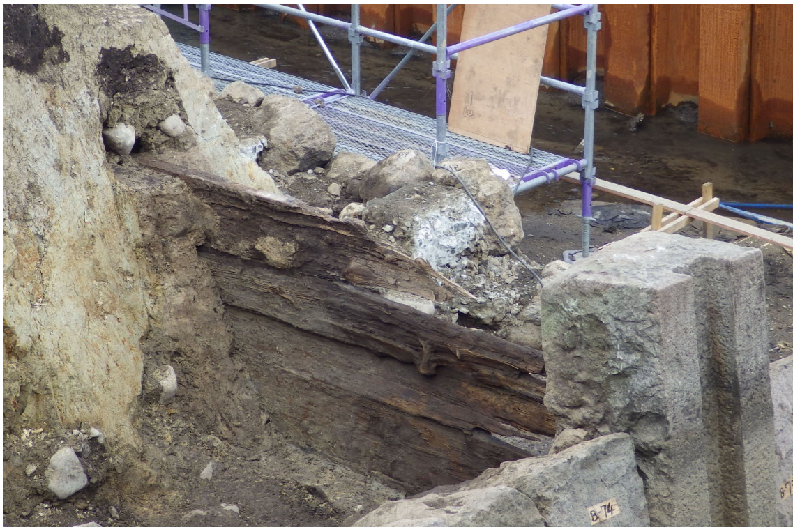
刃金板 (南西から)
