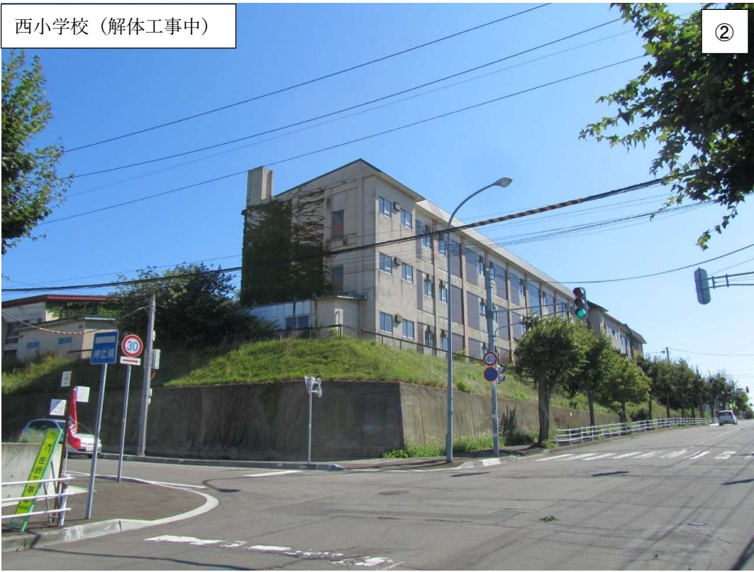
西小学校（解体工事中）
