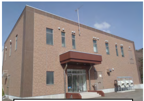
赤川高区浄水場（ろ過施設）
