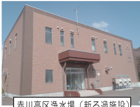
赤川高区浄水場（新ろ過施設）
