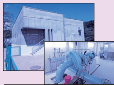
小水力発電所と発電設備
