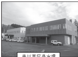
赤川高区浄水場
