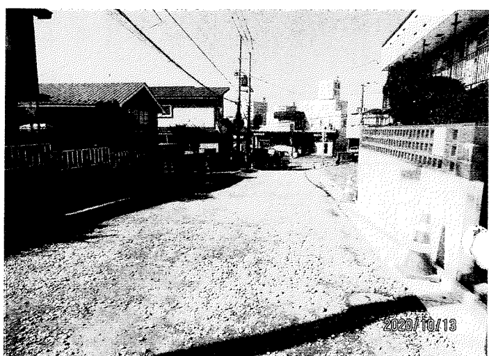
日吉3-11号線ロードヒーティングの延長・整備工事中
