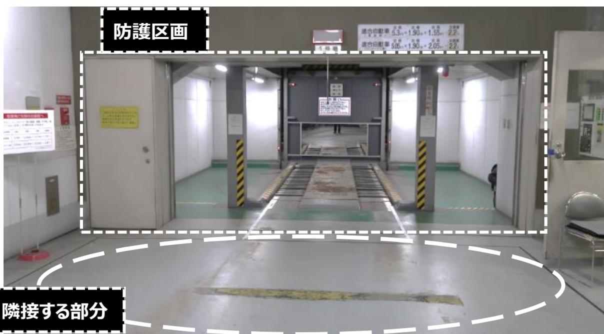
**(5) 消火ガスが防護区画から隣接する部分へ漏洩する可能性があるため、その部分にも近づかない！**
