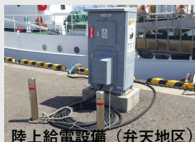
陸上給電設備 (弁天地区)
