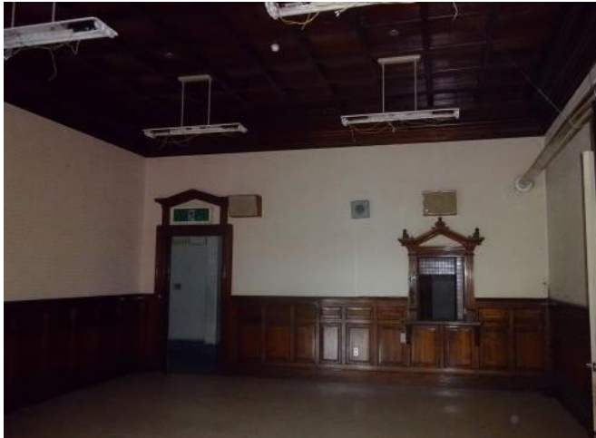
⑭食堂（配膳口・廊下側出入口・腰壁）
