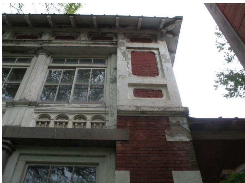
窓枠塗装剥離状況
