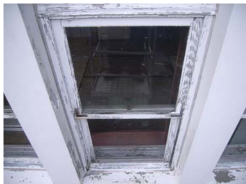
木製窓 塗装剥離状況
