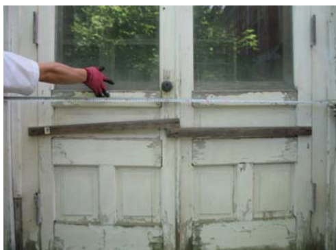
西側出入口扉 破損・塗装剥離状況
