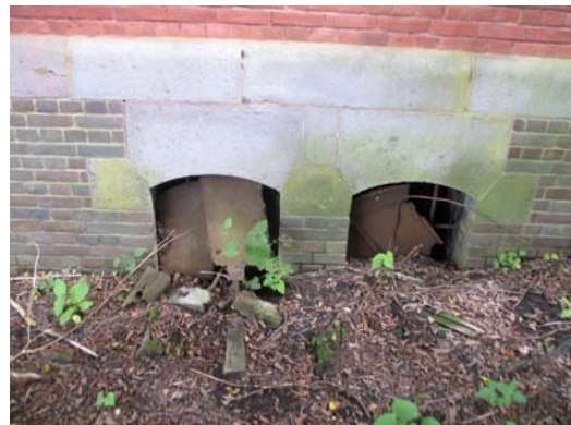
床下換気口(鉄製部)
