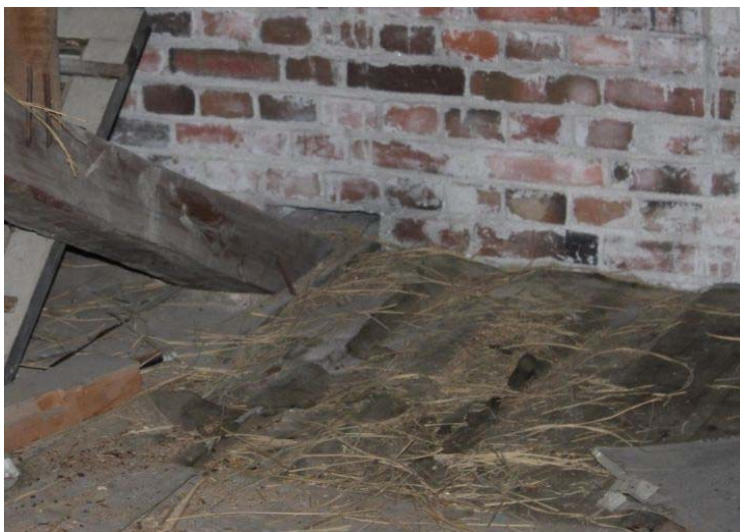
レンガ壁への木梁の挿入
