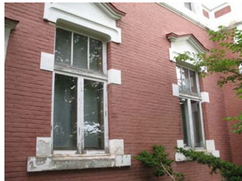
木製窓 塗装剥離状況
