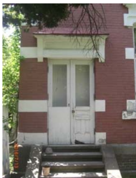
東側事務所出入口扉 破損・塗装剥離状況
