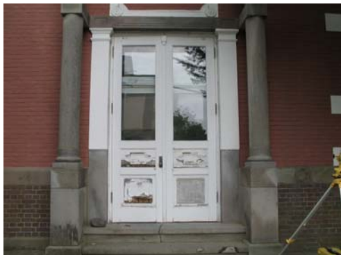
東側正面扉 破損・塗装剥離状況
