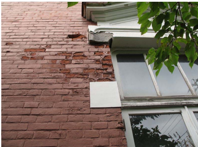
外壁レンガ劣化・破損状況
