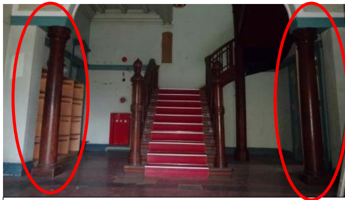
③正面階段付近の柱
