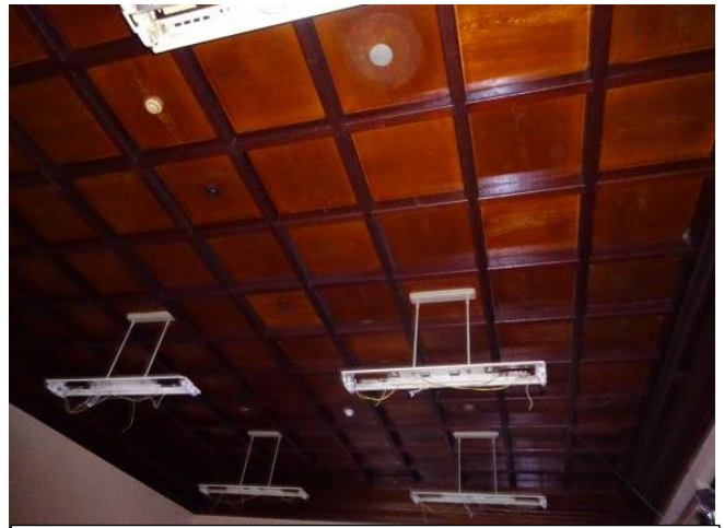
⑮食堂（天井）
