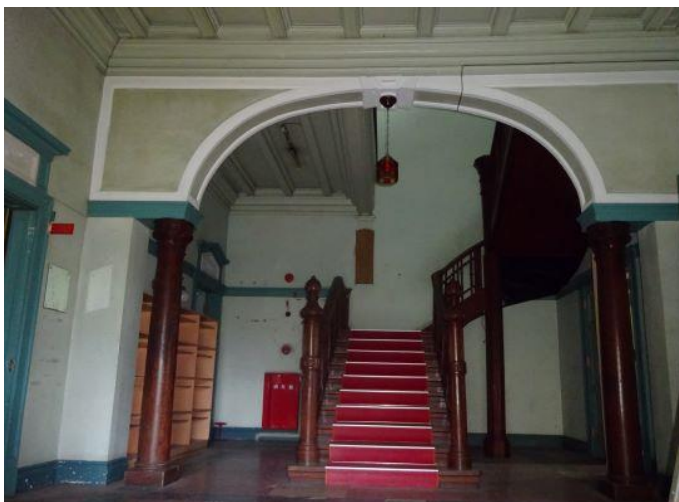
③正面階段付近
