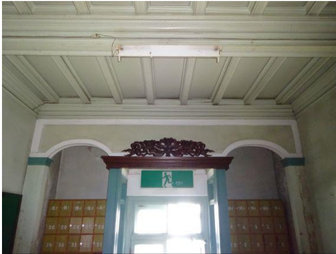
①正面玄関付近
