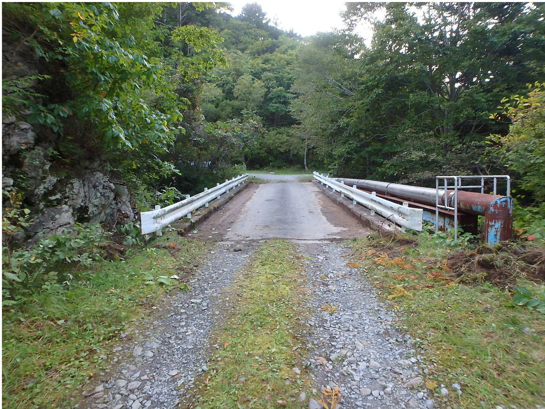
下流側から見た戸井川林道 No. 2号橋
