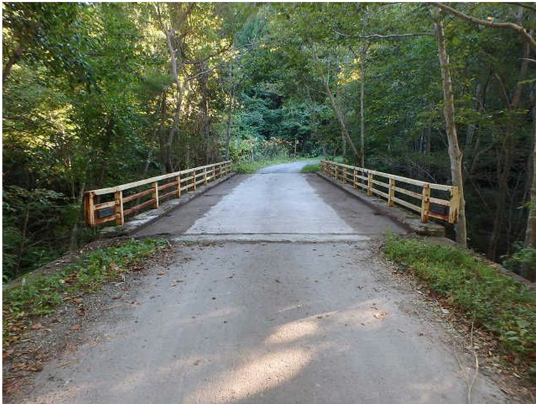
下流側から見た黒羽尻林道 第1号橋
