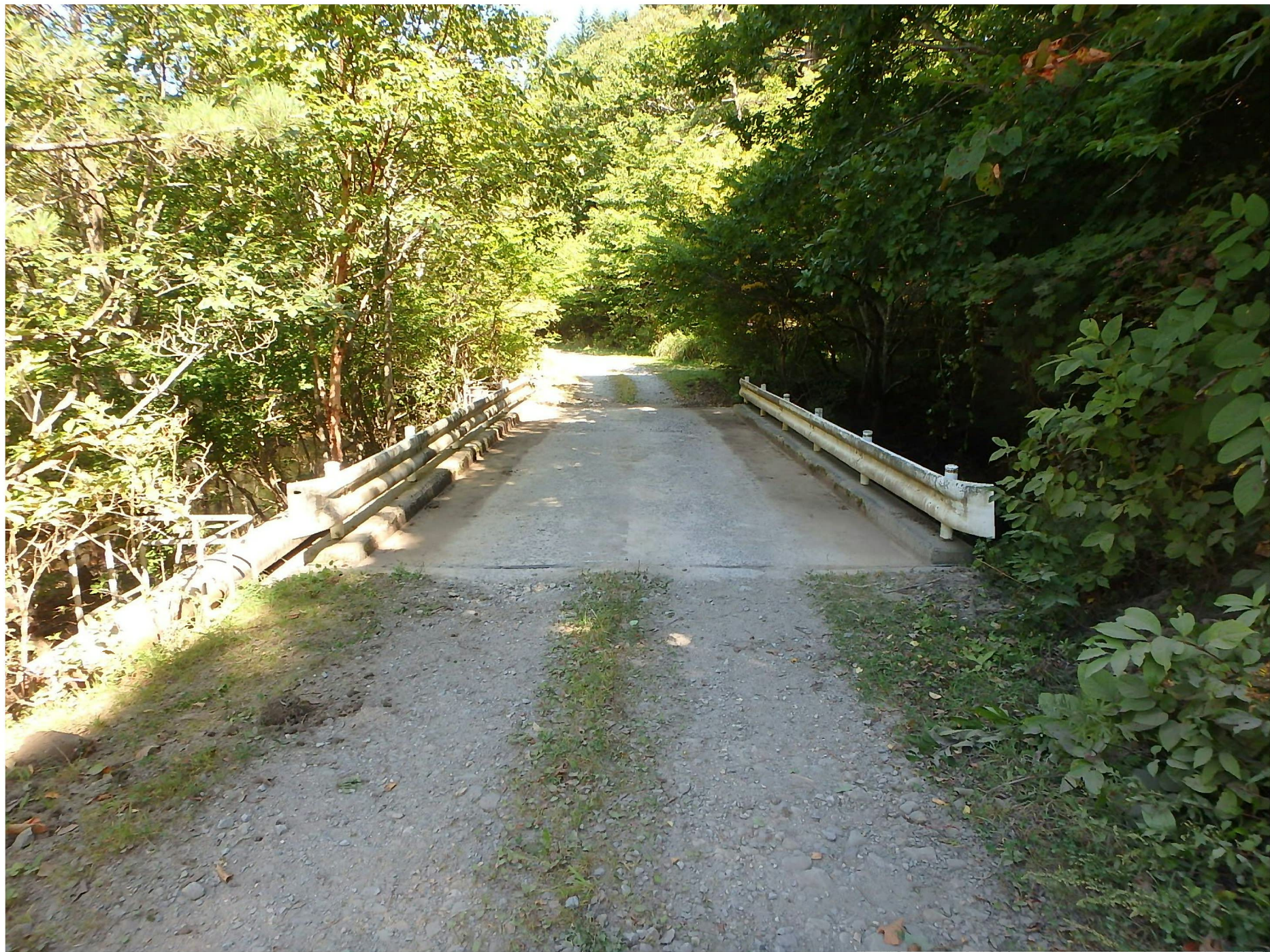
下流側から見た戸井川林道 No. 1 号橋
