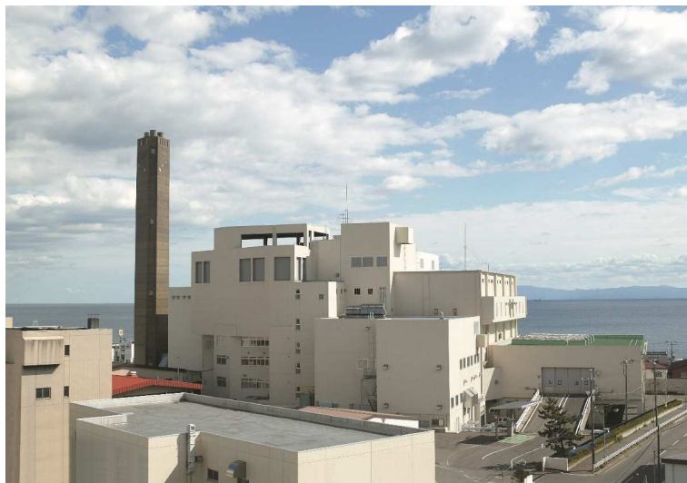
北西から眺める現在の日乃出清掃工場
