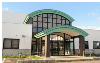
函館市リサイクルセンター
