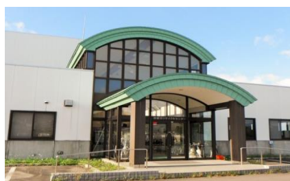
函館市リサイクルセンター
