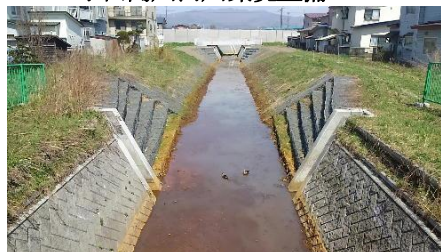
小田島川河川環境整備
