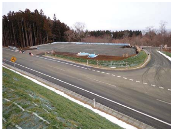
工事進捗状況(2022/12/28)
