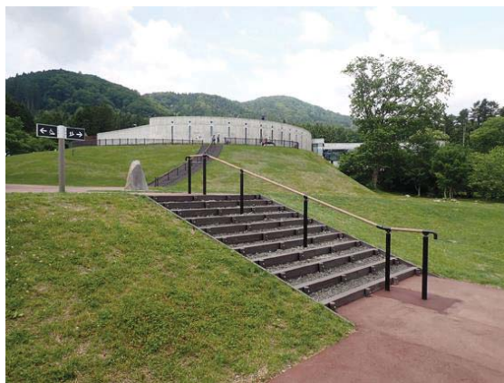
垣ノ島遺跡園路階段に手摺設置
