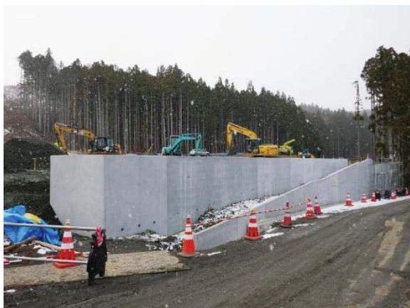
工事進捗状況(2022/12/9)
