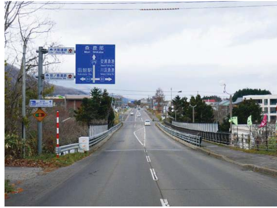
川汲町に設置された道路案内標識
