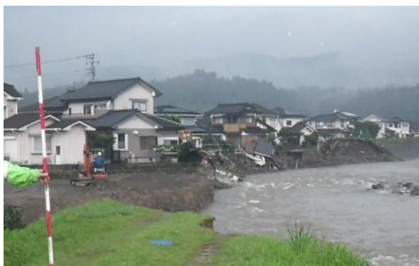
河岸侵食による家屋の倒壊(花月川)
