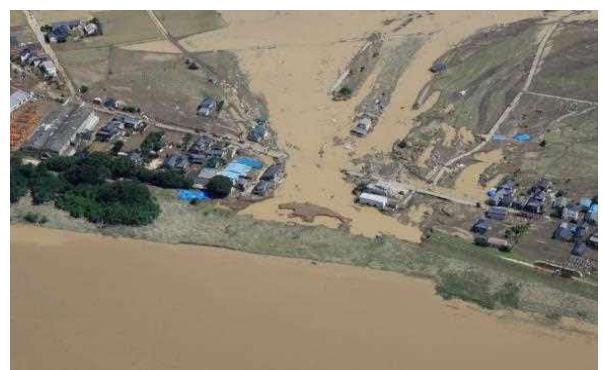
堤防決壊による家屋の流失(鬼怒川)
