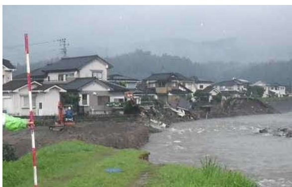
河岸侵食による家屋の倒壊(花月川)
