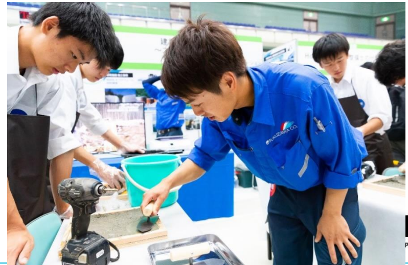
▼コンクリート仕上げ体験（建設会社）
