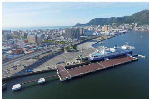
クルーズ船用の「若松ふ頭岸壁」の暫定供用が始まりました。
