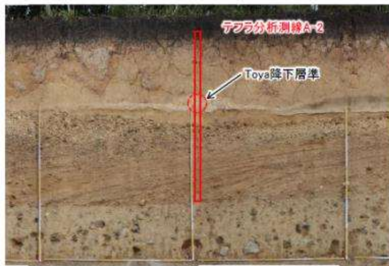
図2.2 法面④詳細画像
