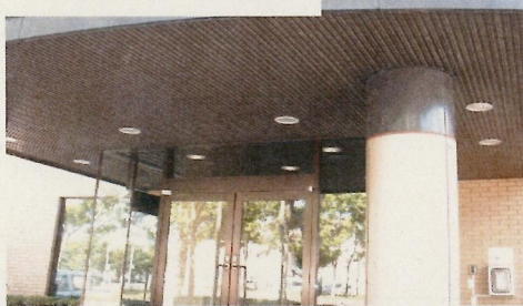
天井板囲い込み後の状態
