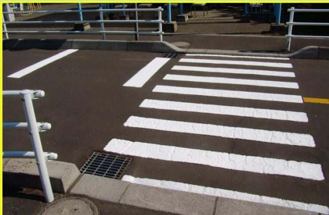
横断歩道：パーゴラ（休憩所）付近
