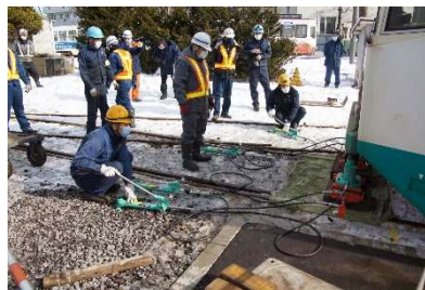
脱線復旧訓練
