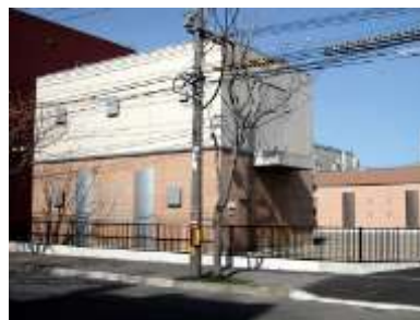
東雲町変電所
