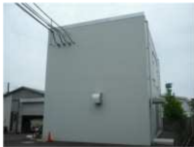
駒場町変電所
