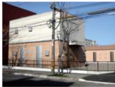
東雲町変電所
