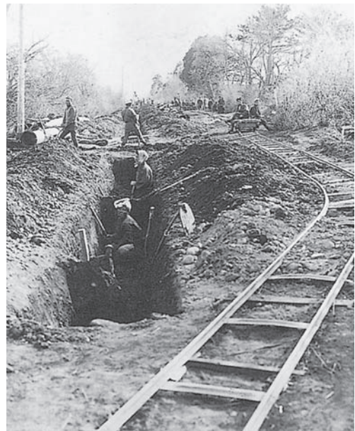
水道工事のようす—明治21(1888)～22年(1889)— (函館市中央図書館蔵)
