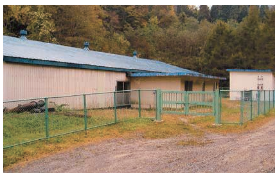
うす じり かき しま 臼尻簡易水道 水源地：垣の島川
