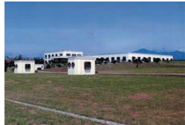
管理棟と配水池（旭岡浄水場） かん り どう はい すい ち あさひ おか
