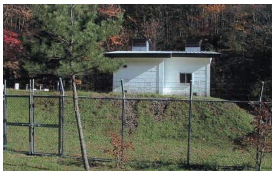
かん そく か 日 浦 簡 易 水 道 緩 速 ろ 過 池
