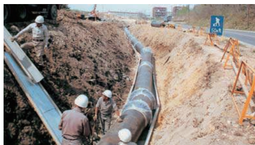
配水管の工事をする人
