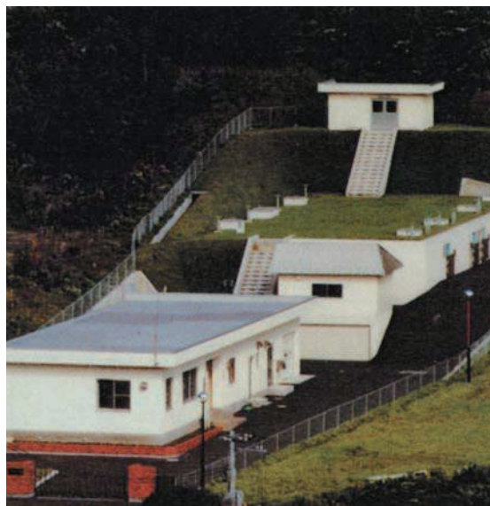
じょう 戸井浄水場
