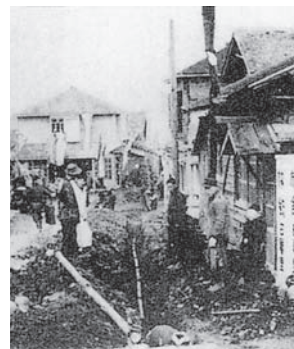
白尻 かん い 簡易水道の工事のようす 昭和28年(1953)
