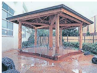
旧市営谷地頭温泉露天風呂 ろてんぶろ
