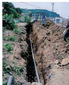
水道を広げる工事 (大船地区)
