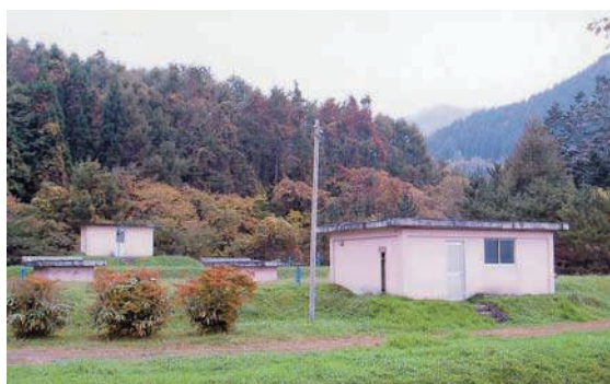
お かつ べ ちょ ぼ ない 尾札部簡易水道 水源地：著保内川
