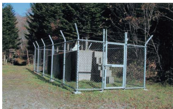
ちん さ ち 日 浦 簡 易 水 道 沈 砂 池
