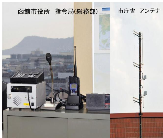
函館市地域防災無線では、(財)移動無線センターが運用する既存の800MHz帯MCAデジタル移動通信システムを採用しており、その利用可能な通信エリアは、旧市域および戸井支所管内のそれぞれ一部となっております。
