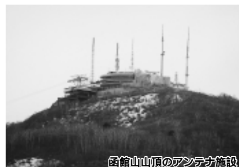
函館山山頂のアンテナ施設
