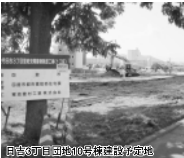
日吉3丁目団地10号棟建設予定地
