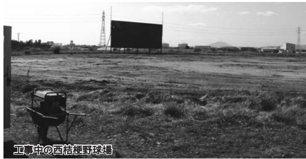
工事中の西桔梗野球場
