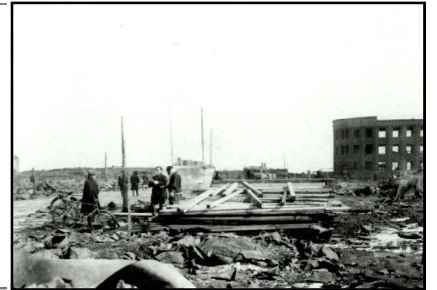
応急住宅の建設 (右後の建物は焼失を免れた 旧旭中学校)
