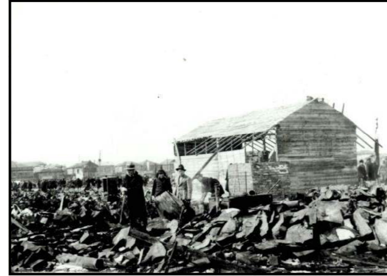
応急住宅の建設
