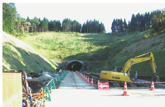
工事が進む国道 278 号（尾札部バイパス）
