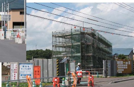
新外環状線の整備が進む（仮称）赤川インターチェンジ付近
