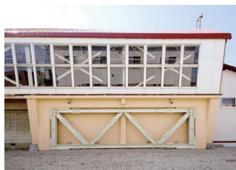
体育館の耐震改修（五稜中学校）
