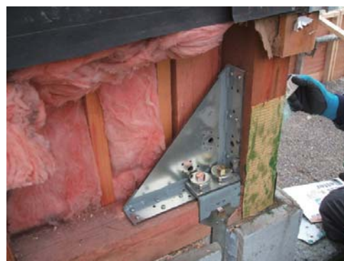
木造家屋の耐震改修
